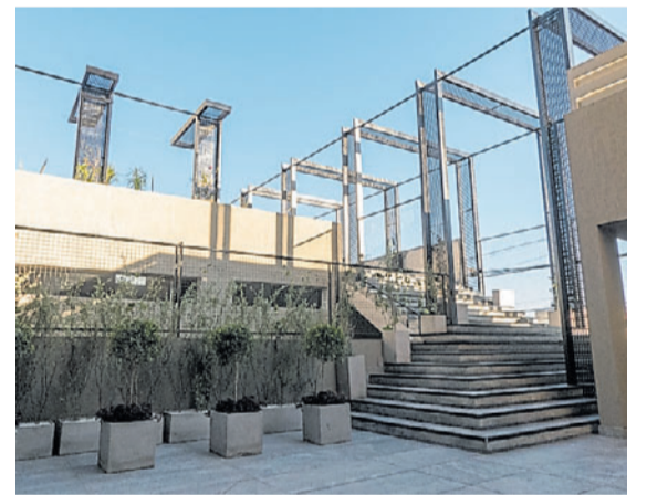
SERVICIOS. En las terrazas del segundo piso.
