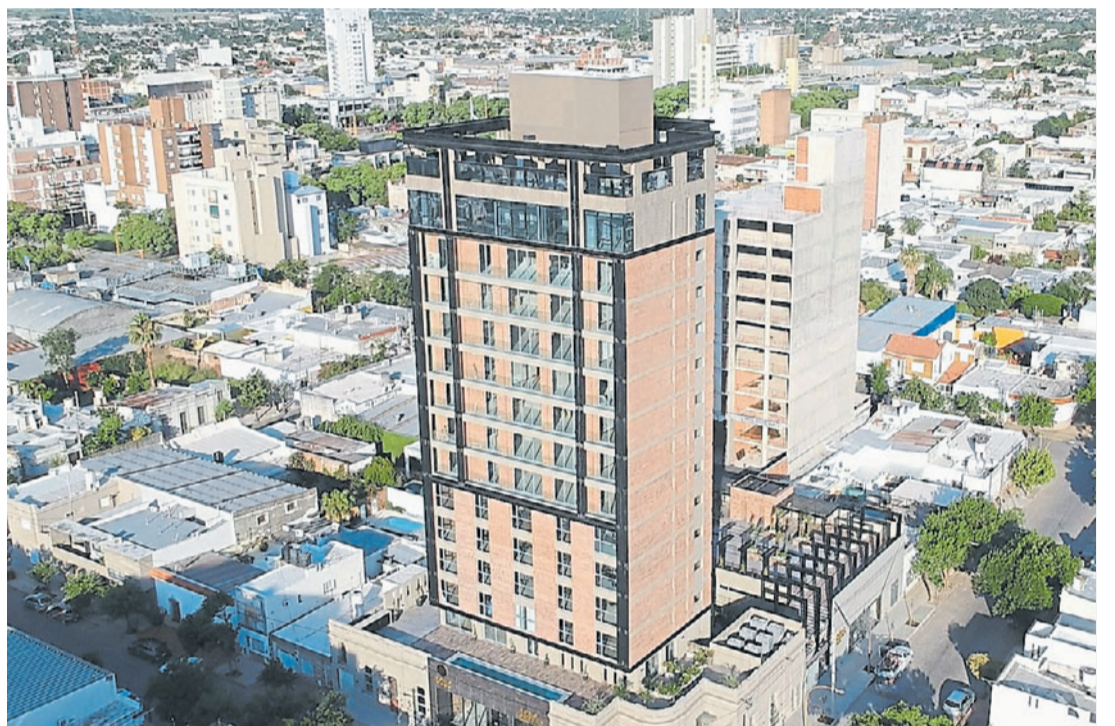
HITO. El edificio se levanta sobre varias casonas existentes, conservando sus fachadas.
